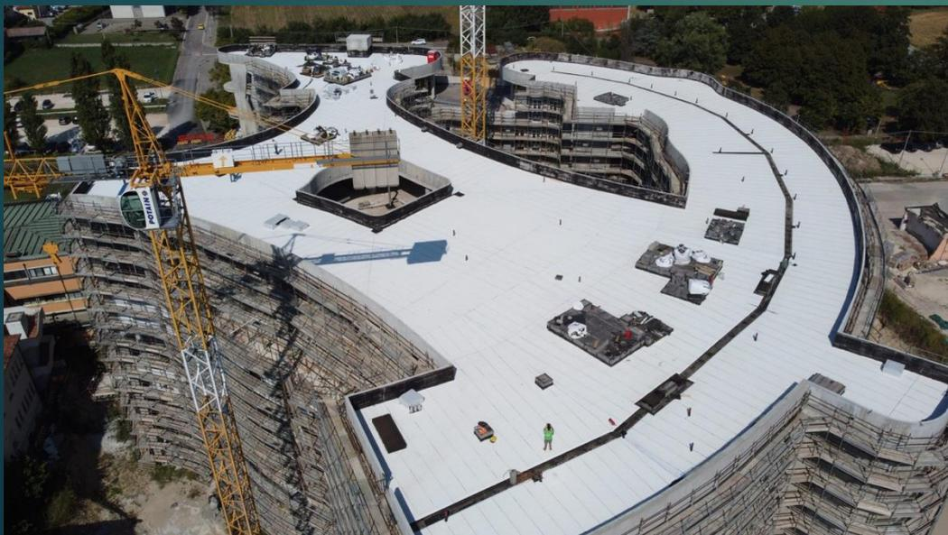
Un' impermeabilizzazione bituminosa a freddo è un tipo di rivestimento impermeabilizzante simile a quello a caldo, ma che non richiede il riscaldamento del bitume. Invece, il bitume viene miscelato con polimeri o altre sostanze che ne aumentano la fluidità a basse temperature, e viene applicato sulla superficie da proteggere con l'uso di un rullo in totale aderenza.
